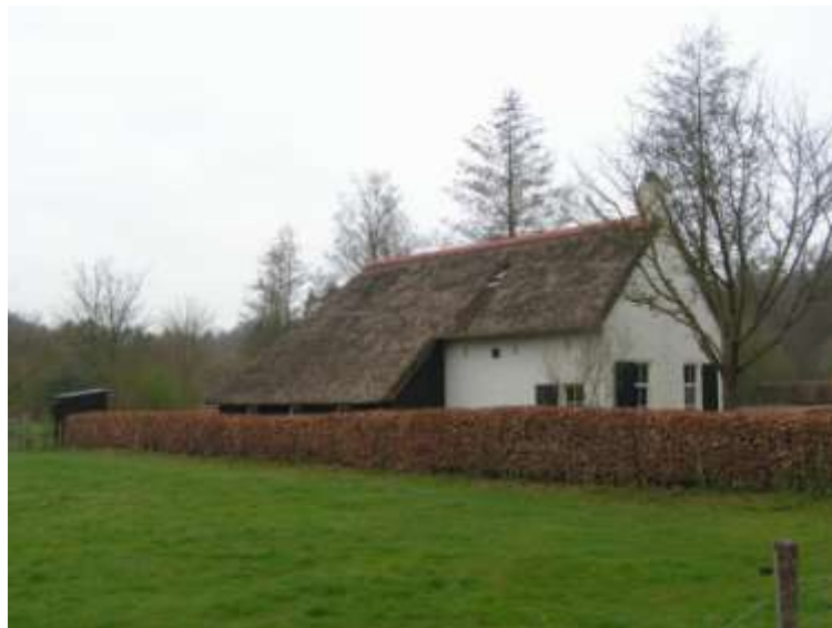
Voormalige (gerestaureerde) kolonistenwoning in Frederiksoord (foto Roelof Hazelhoff)
